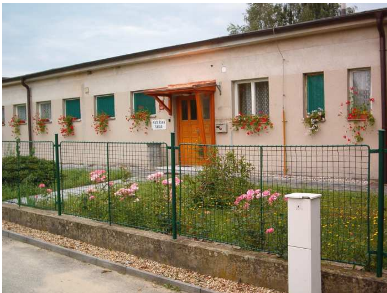
MŠ před rekonstrukcí
