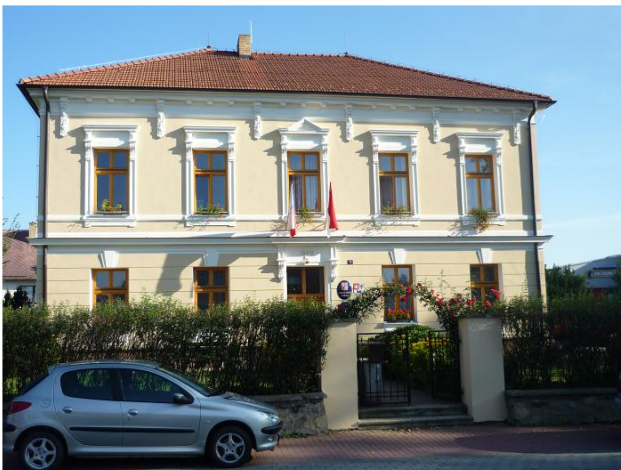
Stavební úpravy - nová fasáda OÚ
