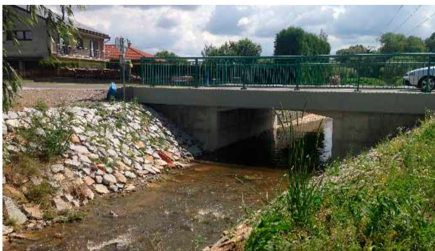
Výstavba mostu na silnici III. třídy č. III/14326 směr Černý Dub - podzim 2019
