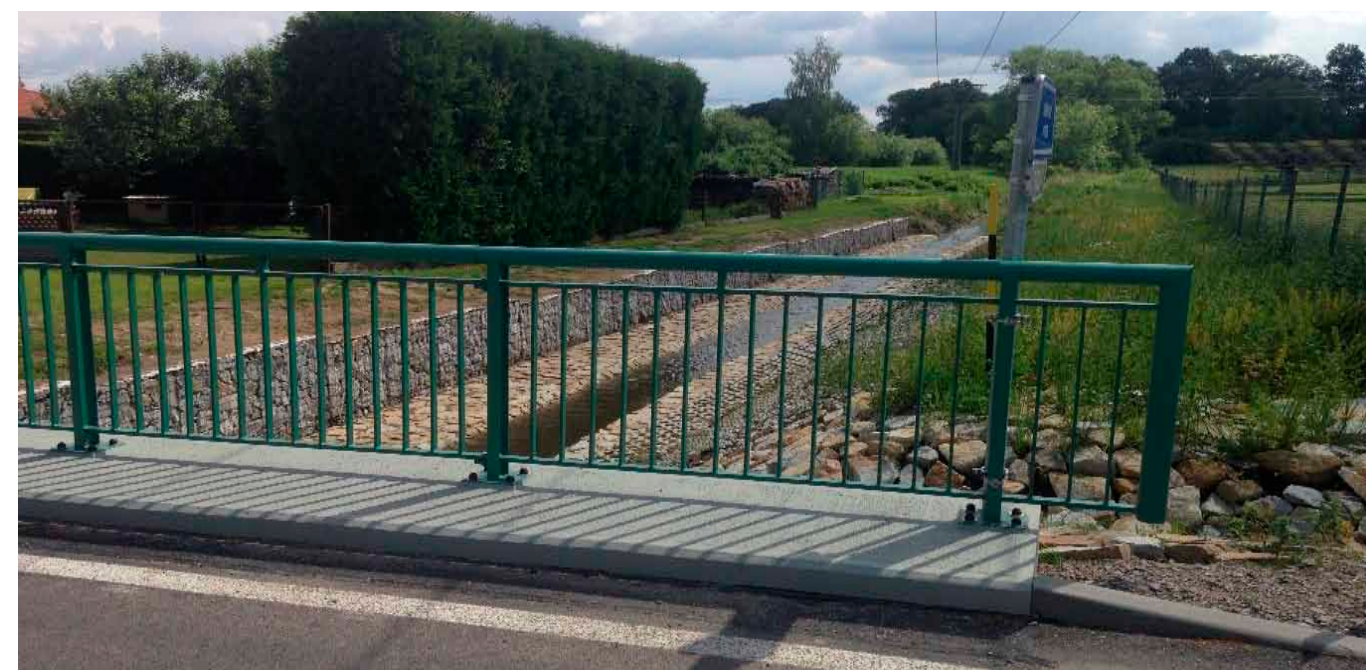
Výstavba opěrné zdi s vydlážděním koryta u mostu směr Černý Dub - podzim 2019
