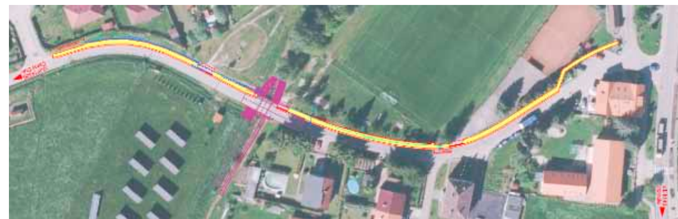
Výstavba chodníku Nové Homole - léto 2020
