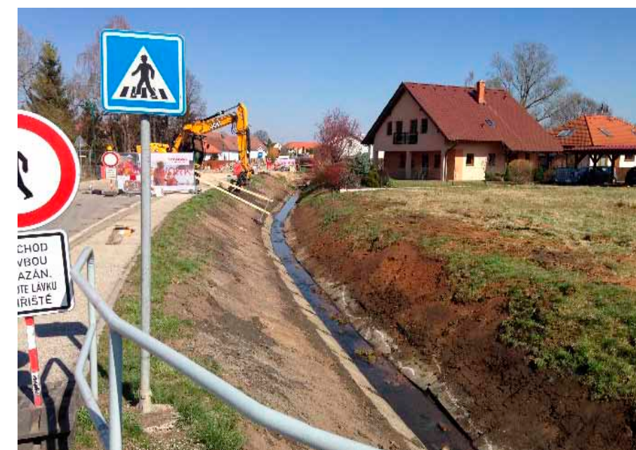
Výstavba mostu na silnici II. třídy č. II/143 směr Křemže - jaro 2020
